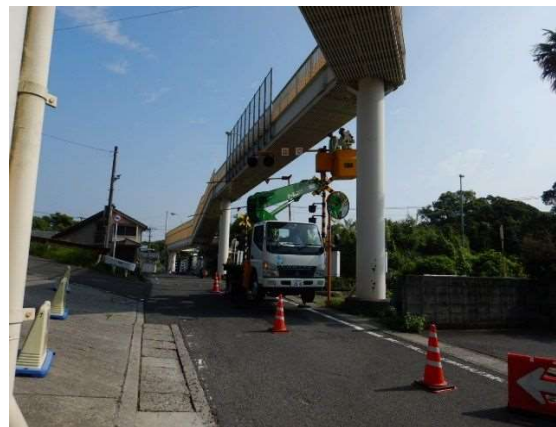
定期点検（近接目視）：高所作業車
