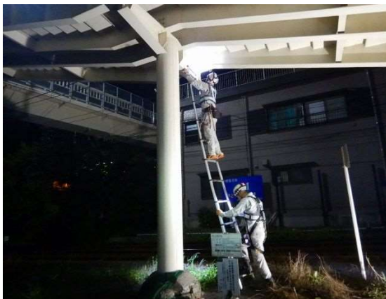
定期点検（近接目視）：梯子点検
