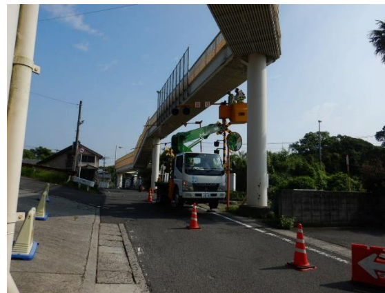
定期点検（近接目視）：高所作業車
