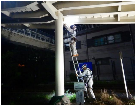
定期点検（近接目視）：梯子点検
