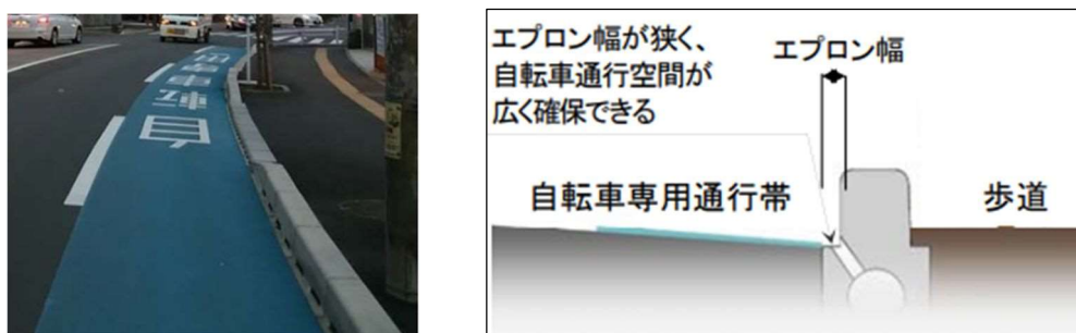
図 3.8 側溝をエプロン幅の狭いものに置き換えた事例
