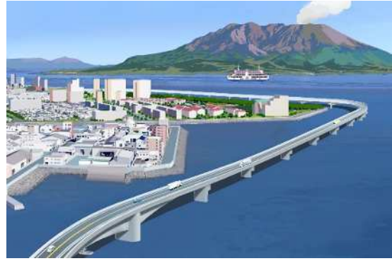
〔産業活動を支える臨港道路整備〕
