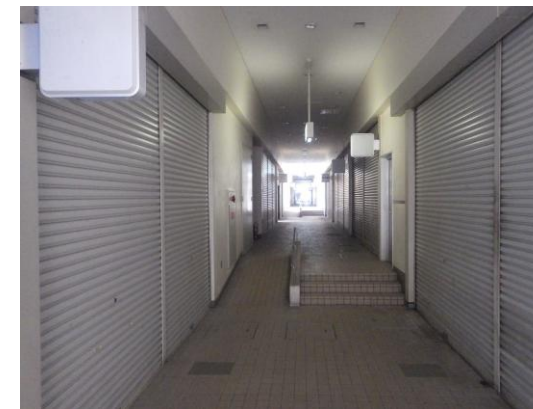
③ 1号館内部
