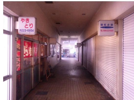
② 2号館内部
