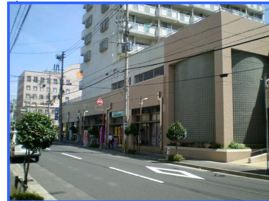
⑥ 外観(中央部)
