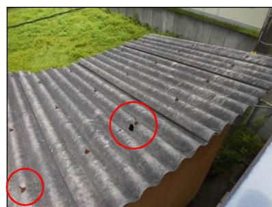
破損、ボルトのさび
