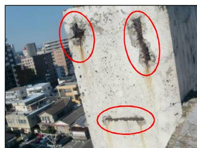
欠け、鉄筋の露出
