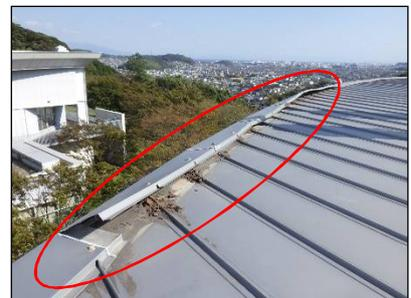
ボルトさび、強風による破損
