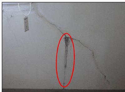
ひび割れ部の漏水跡
