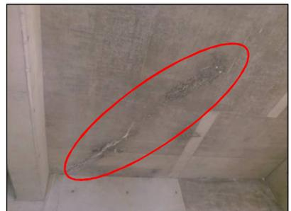
ひび割れ、漏水跡（直接天井）
