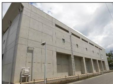
コンクリート打放し仕上げは、コンクリート面を直接仕上げとしたものです。
