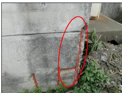
欠け、鉄筋の露出
