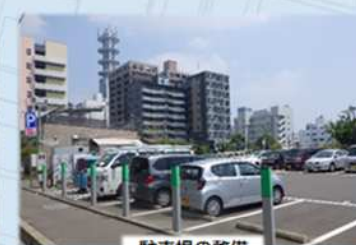
駐車場の整備
