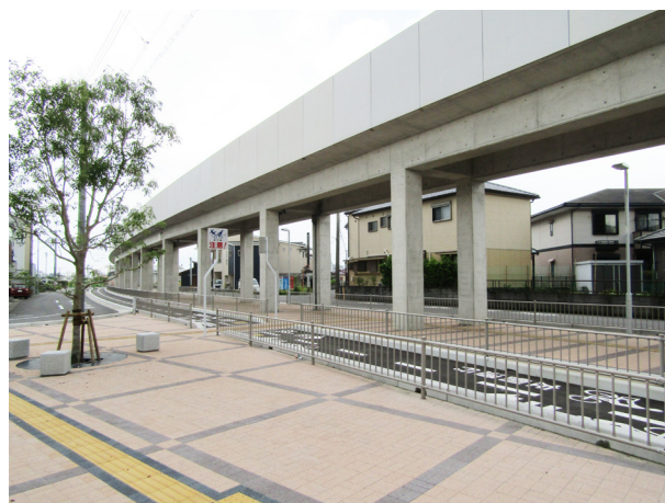
写真 10-6 遊歩道（旧田辺第 1 踏切付近）
