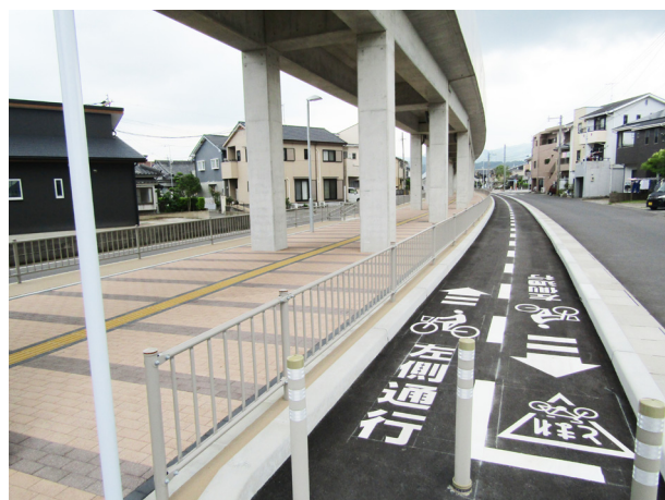
写真 10-5 遊歩道（旧森永踏切付近）
