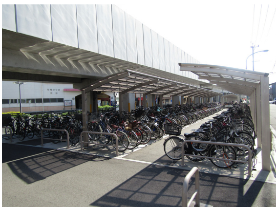
写真 10-2 市営谷山電停自転車等駐車場
