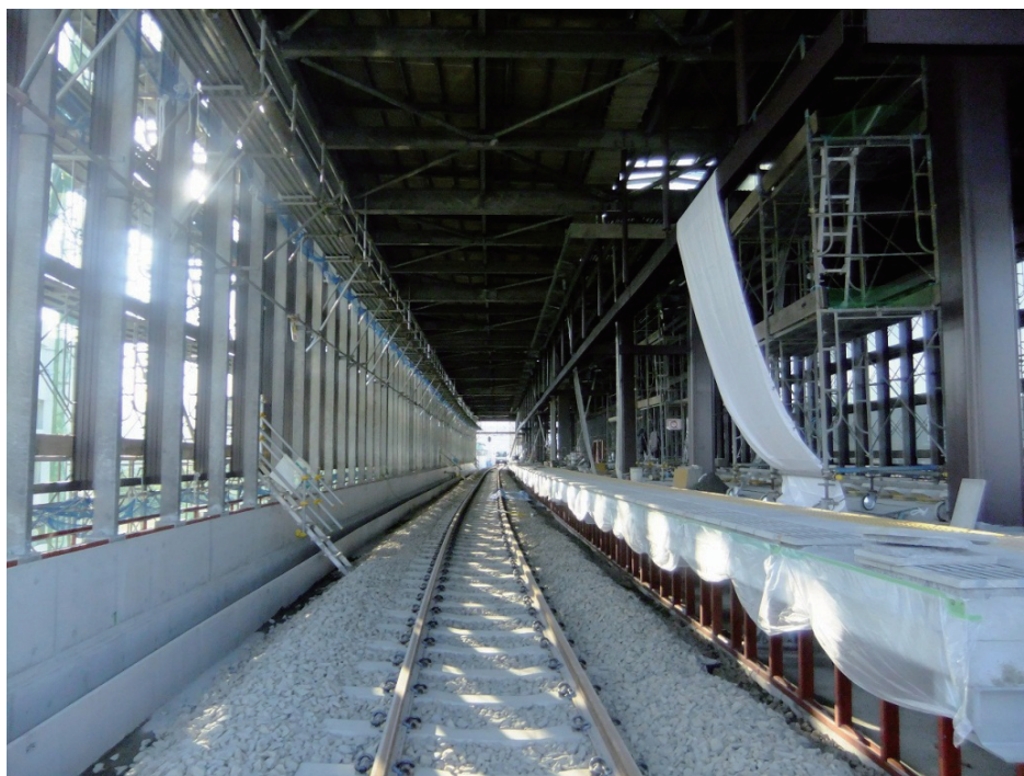
写真 6-15 乗降場工事、軌道工事
