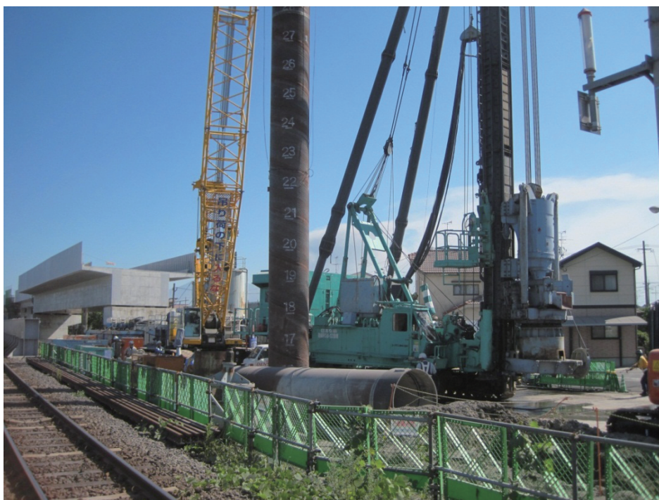
写真 6-11 高架橋基礎工事（慈眼寺駅部工区）
