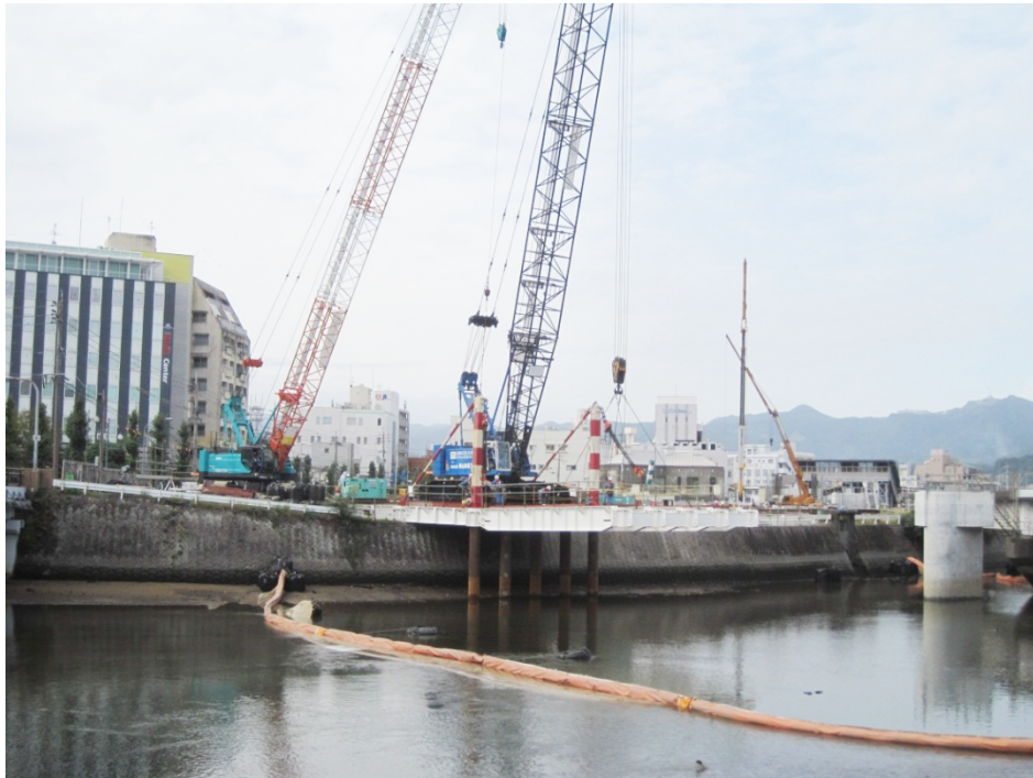
写真 6-6 永田川橋りょう鋼管打設
