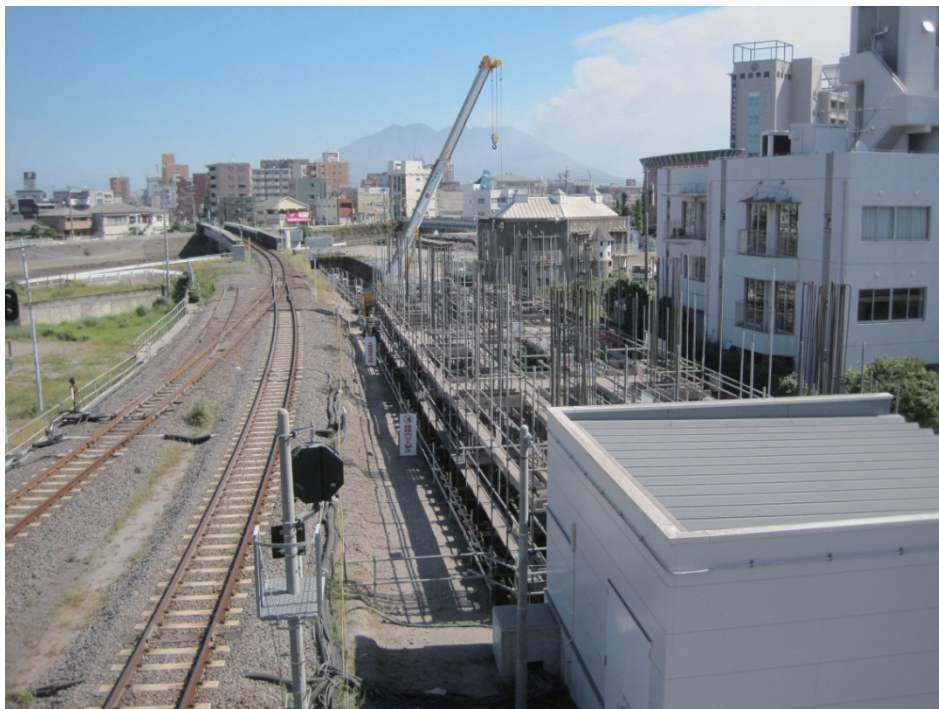
写真 6-7 高架橋躯体工事（谷山駅部工区）
