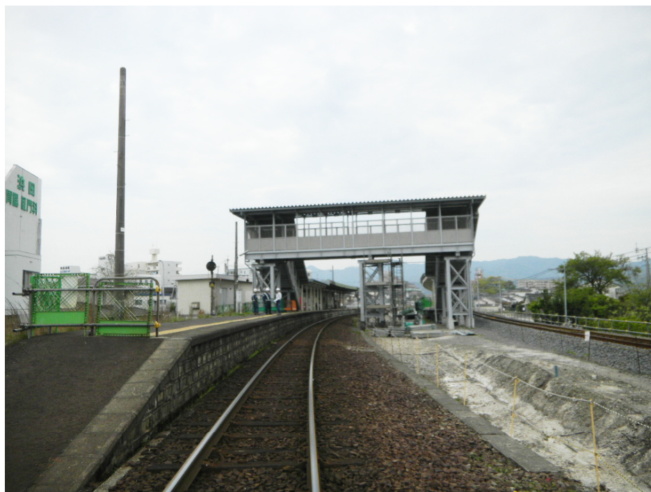
写真 6-4 谷山駅仮こ線橋
