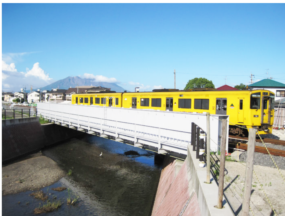
写真 6-5 木之下川仮線橋りょう
