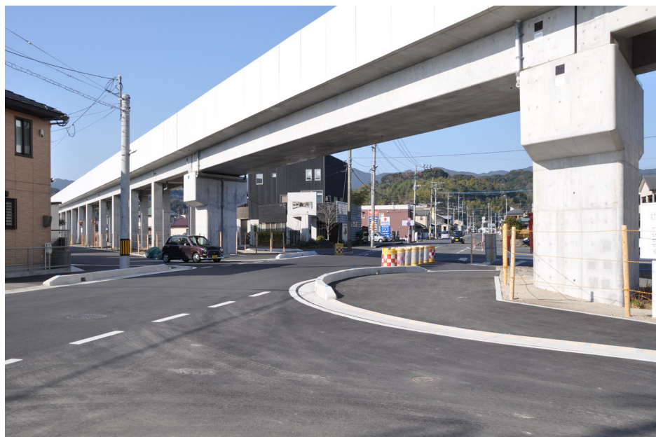
写真 6-19 交差道路 (旧大久保踏切)
