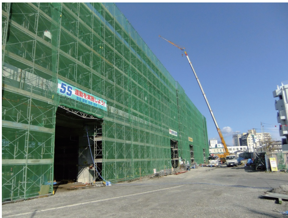
写真 6-14 駅舎工事（谷山駅）
