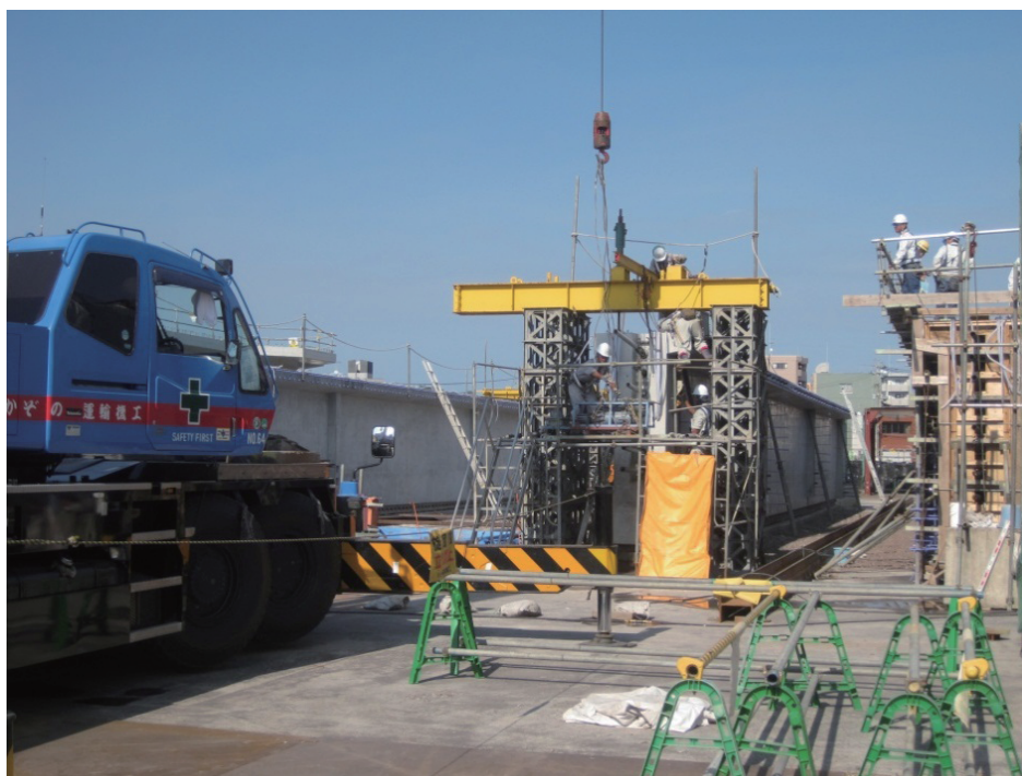
写真 6-9 永田川橋りょう上部工製作状況
