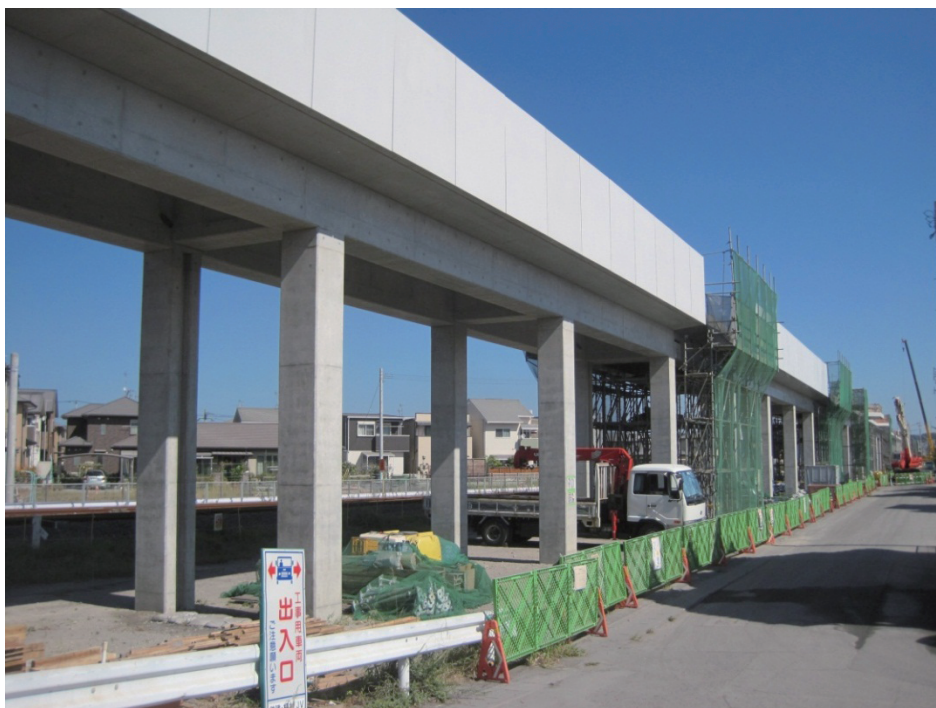
写真 6-10 高架橋躯体工事（本庄工区）
