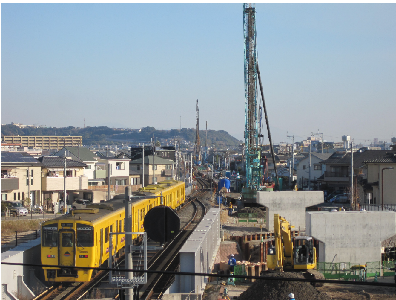
高架橋施工状況
