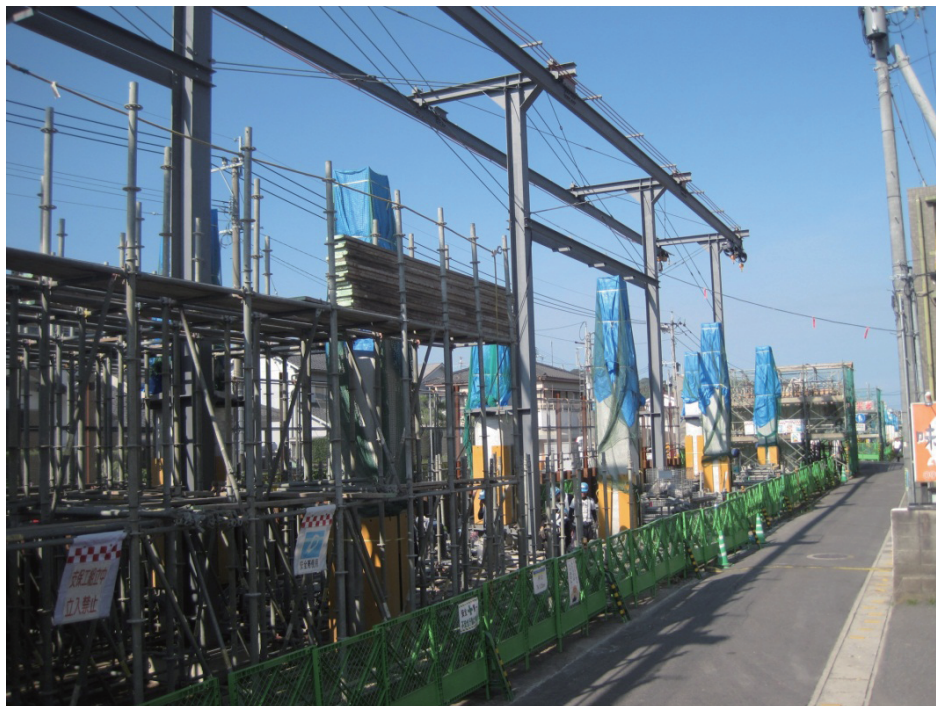
写真 6-8 高架橋躯体工事 (中村工区)
