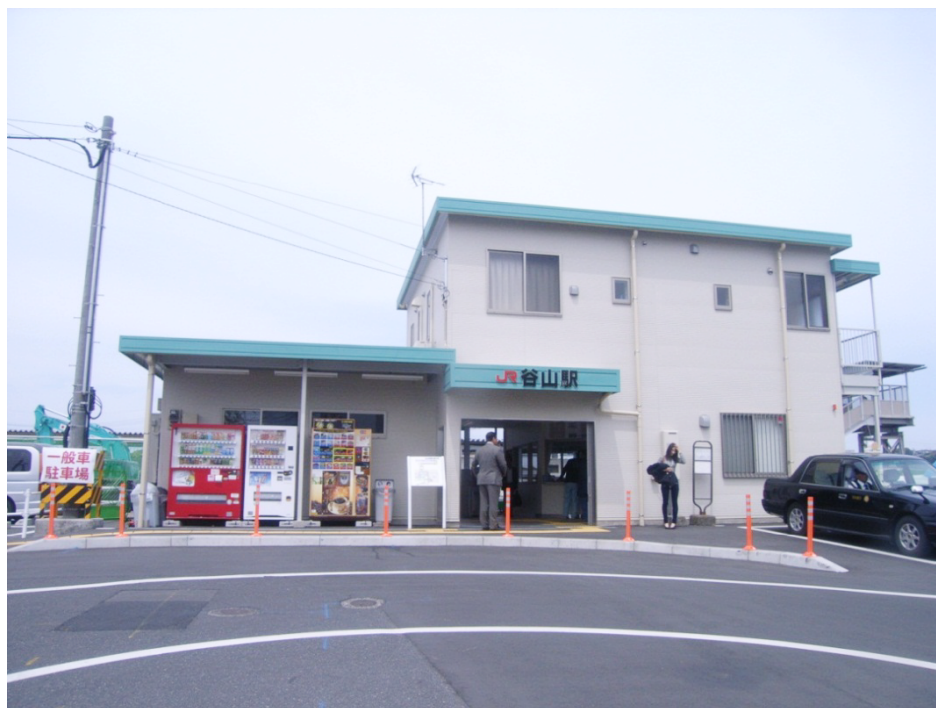
写真 6-3 谷山駅 仮駅舎
