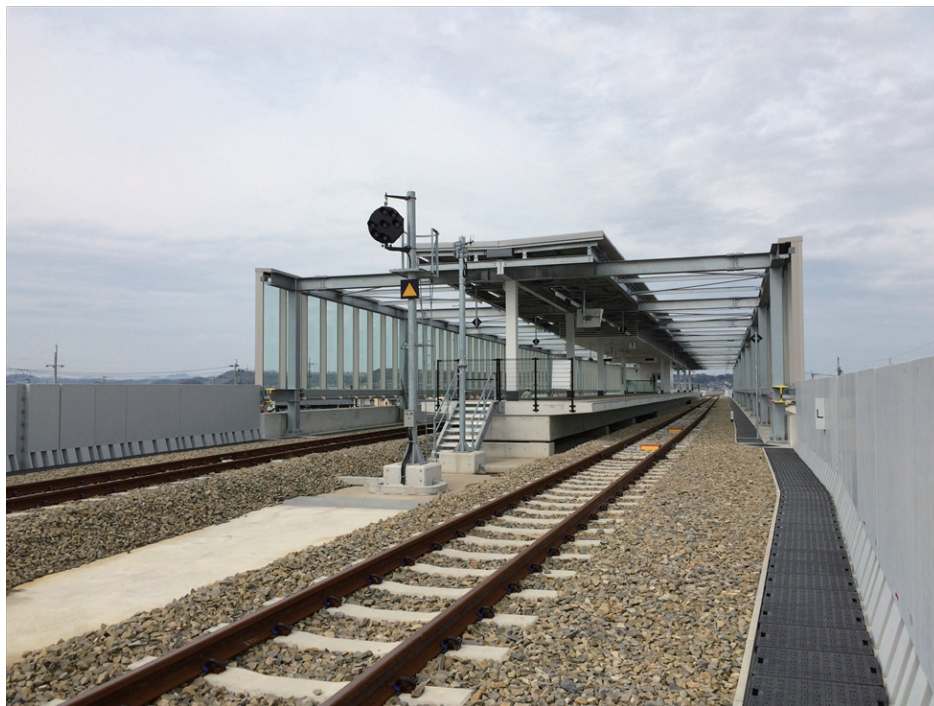
写真 6-16 慈眼寺駅完成写真
