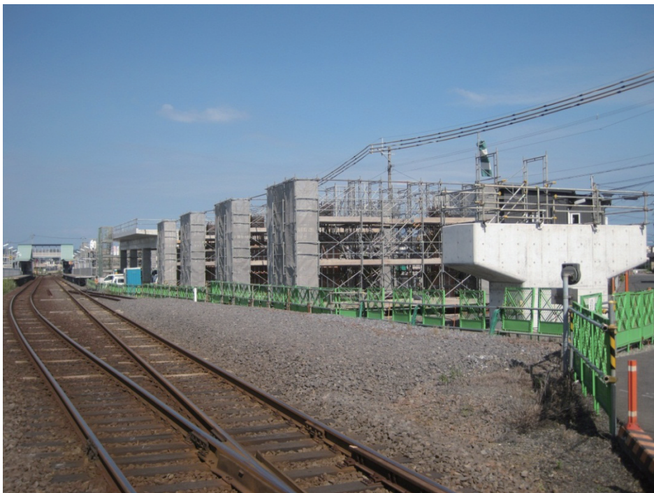
写真 6-13 高架橋躯体工事（慈眼寺駅部工区）
