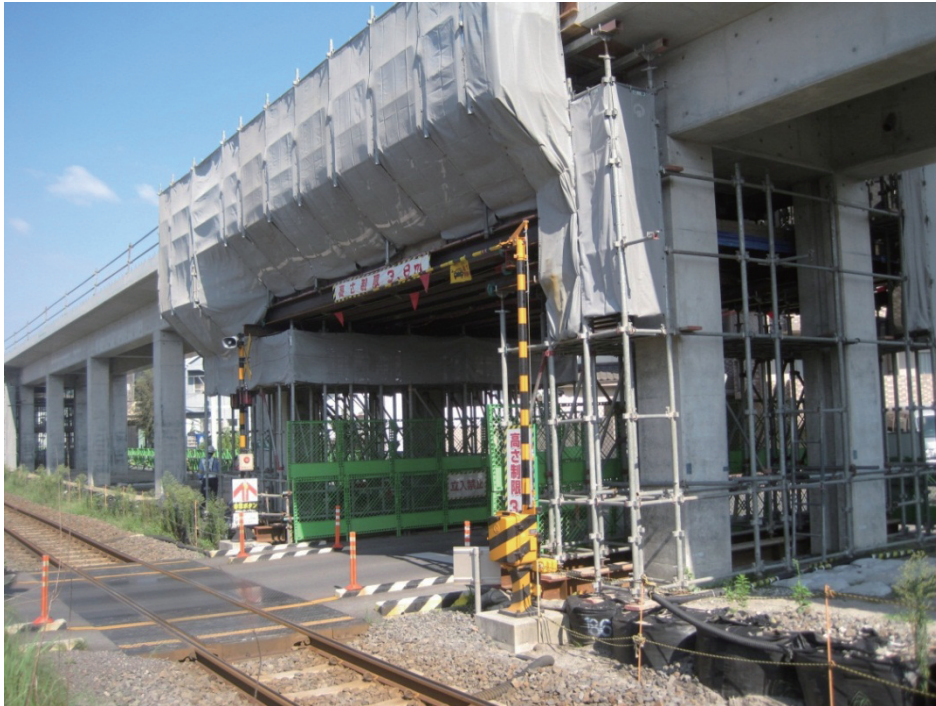
写真 6-12 高架橋躯体工事（陣之平工区）
