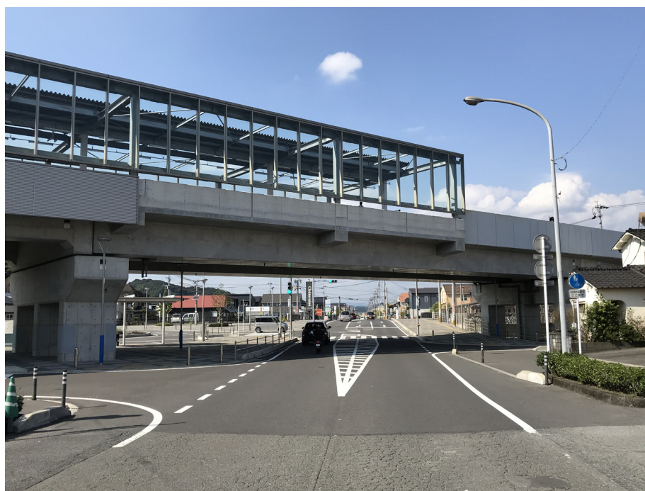
写真 8-5 御所下和田名線（御所下和田名線架道橋）
