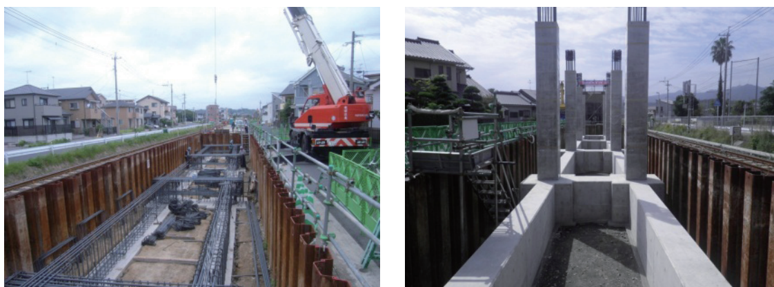
写真 8-22 下部工施工状況
