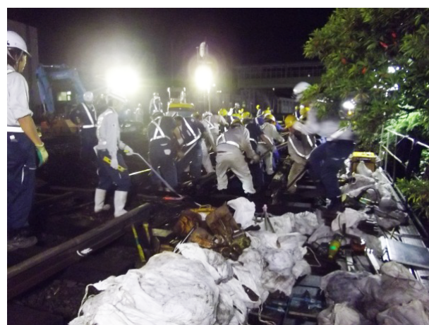
写真 8-29 線路切替作業
