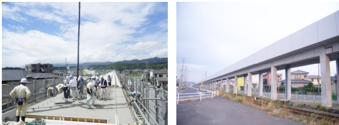
写真 8-24 コンクリート打設状況、高架橋完成
