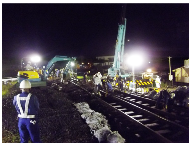
写真 8-29 線路切替作業
