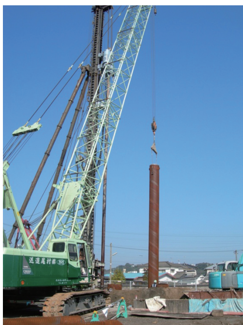
写真 8-26 鋼管ソイルセメント杭施工状況
