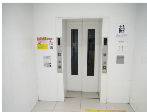
写真 8-38 昇降設備（慈眼寺駅）
