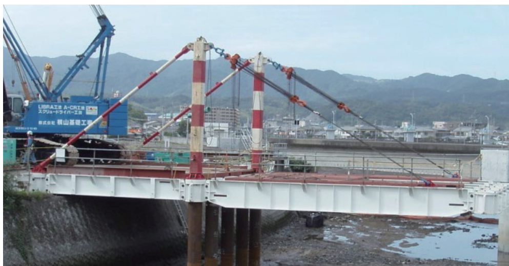
写真 8-27 永田川橋りょう仮栈橋施工状況
