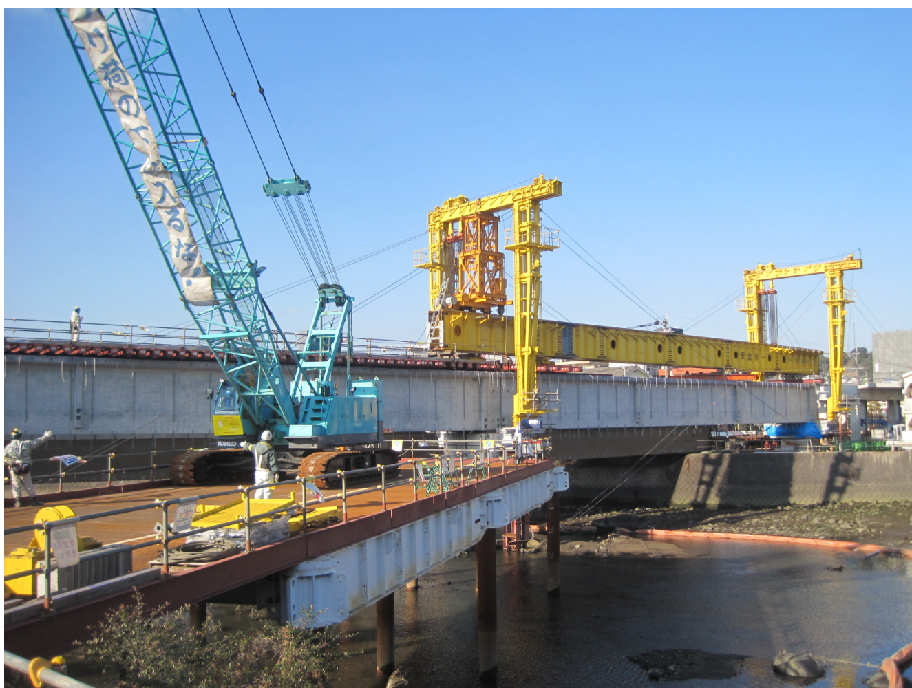
永田川橋りょう施工状況
