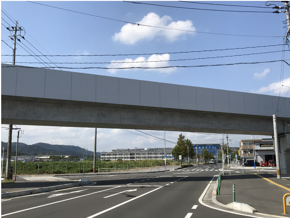
写真 8-3 惣福森山線（向川原森山線架道橋）
