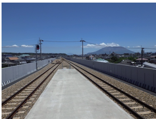
写真 8-28 軌道敷設状況
