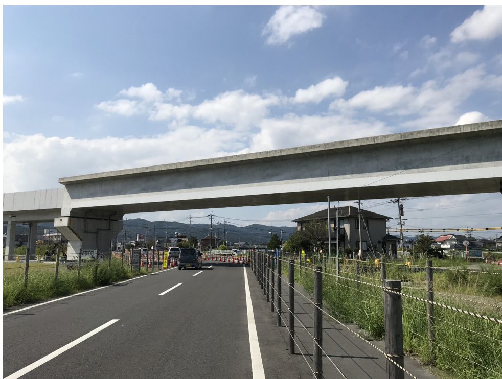
写真 8-2 南清見諏訪線（南清見諏訪線架道橋）
