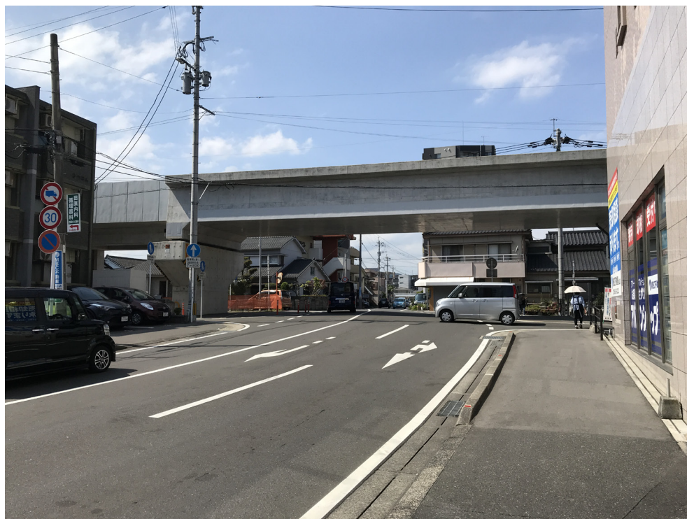
写真 8-1 北清見薬師堂線（中村架道橋）
