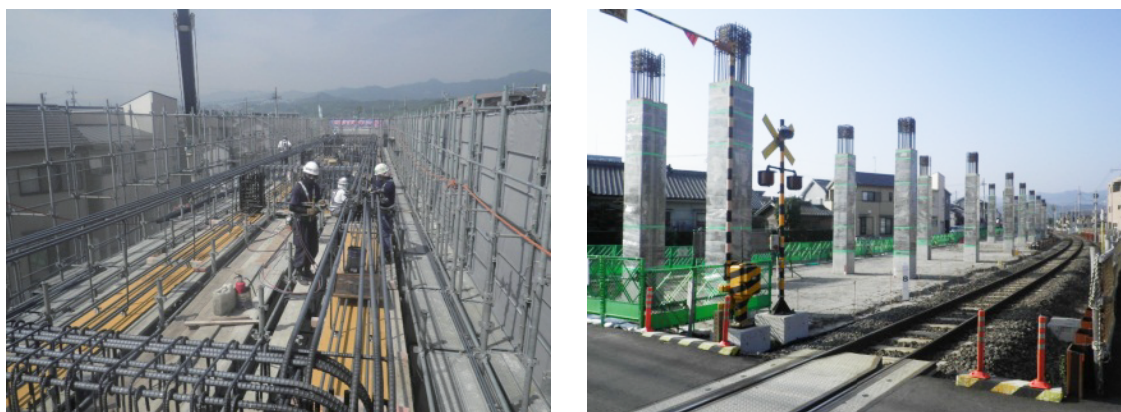
写真 8-23 上部工施工状況
