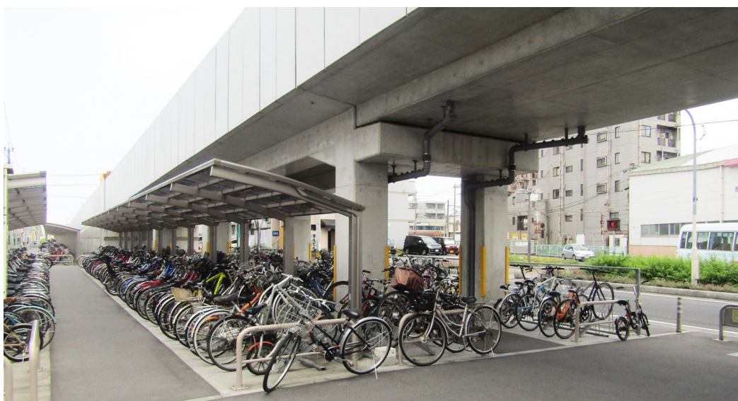
写真 9-6 市営谷山電停自転車等駐車場
