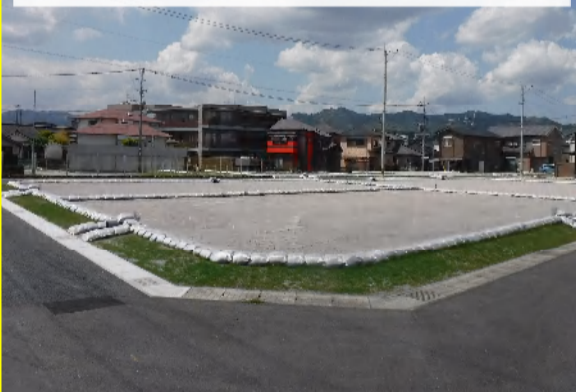
④ 道路築造・宅地整地工事が完了しました。
