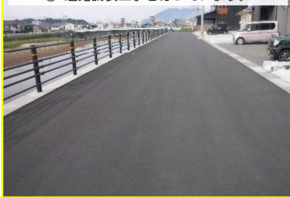
⑤ 道路舗装工事をしています。
