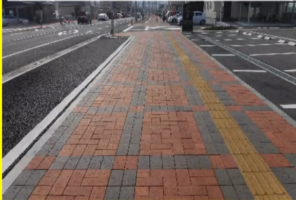
② 歩道舗装工事が完了しました。
