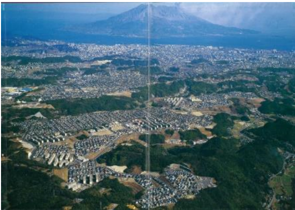
■ 中心市街地周辺の住宅団地
