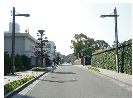
地区東側(春日町交差点側)から通りを望む
