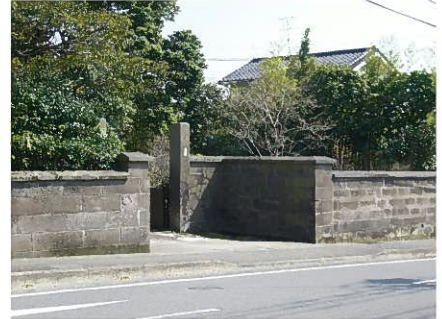
南洲門前通り地区に現存する石塀
