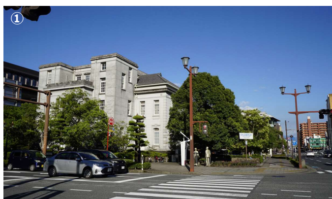
昼間は交差点からもその瀟洒な建物のようすが感じられる県政記念館。
