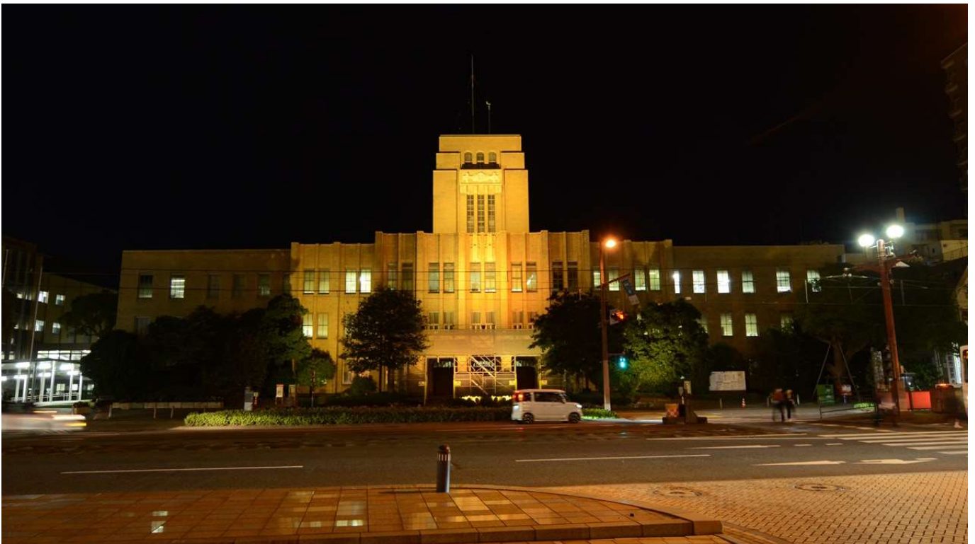
ナトリウムランプを光源とした投光器でライトアップされており、建物の中央が各階に置かれた照明器具で強調されている。
