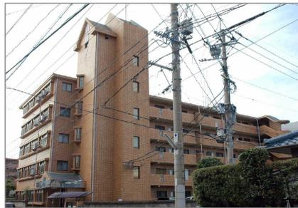
外壁と同じ素材を立ち上げ、建築設備を内部に配置し、建物と一体的に見せている
