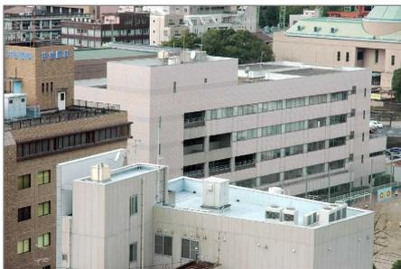
壁面の立ち上げにより屋上設備を遮へいしている
