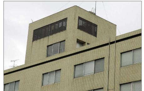
屋上の建築設備を外壁と同じ素材の立ち上げと部分的なルーバーでの遮へいにより、建物と一体的に見せている
