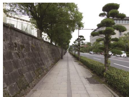
石積みによる擁壁
