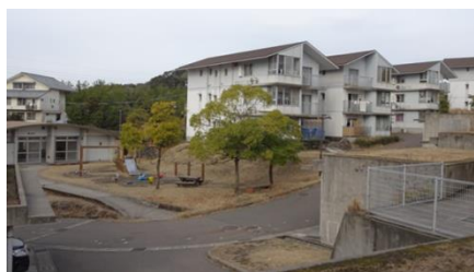
【降灰対策例】急勾配の屋根（県営住宅桜島団地）
