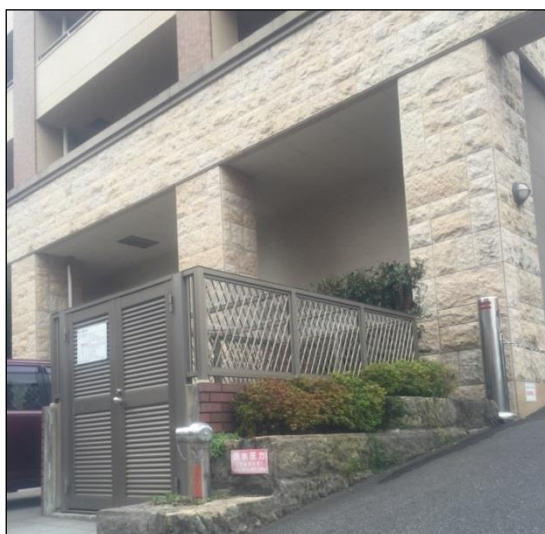
ごみ置き場に、扉等や植栽を設け、公共の場からごみが見えないように配慮している
