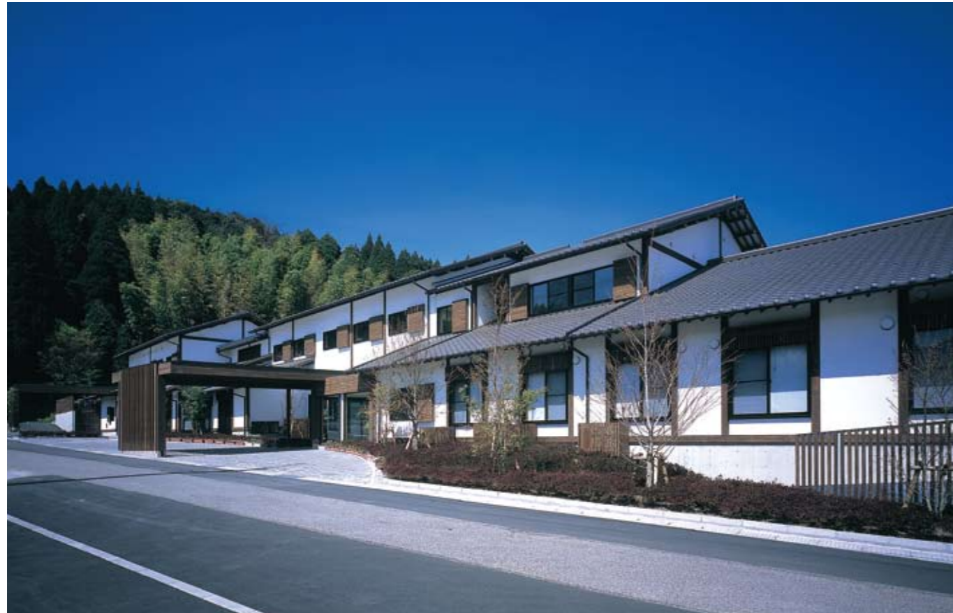
南側より見る
