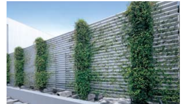
直方体形状の「緑化ブロック」からつる状の植物が伸びてルーバーを覆う
