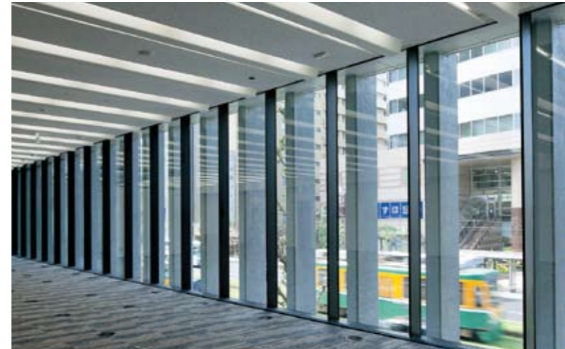
室内に柱が無く、床から天井までガラスとした開放的な窓廻り
