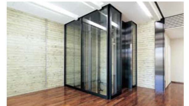
ガラス越しに杉型枠の壁が見えるシースルーのエレベーターシャフト
