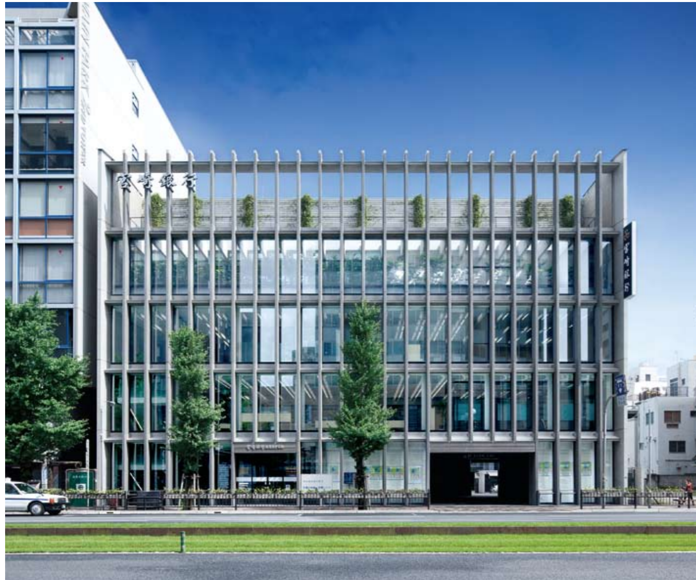
プレキャストコンクリートの細いリブ状の列柱で構成した軽快なファサード 緑の壁は日々、成長を続けている
