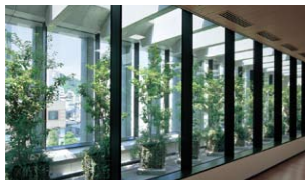
格子のカゴ状の植木鉢部分にも植栽を施し、中木で緑化した4階のテラス
