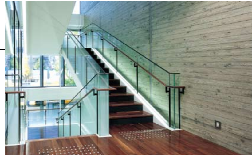
宮崎県が生産日本一を誇る杉による型枠を使用した打ち放しコンクリート壁でできた空間
