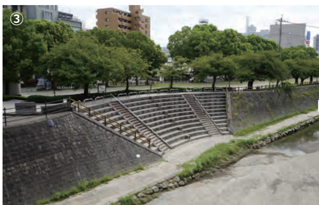
護岸に現れる階段状の広場。親水空間として非常に魅力的に感じられる。
