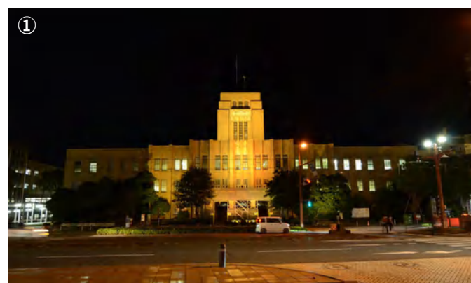
① ナトリウム灯を光源とした投光器により、レリーフのある建物中央部を強調するように照らし出されている。セットバックする建物の形状に沿って器具が配置され、全体に光が届いている。
