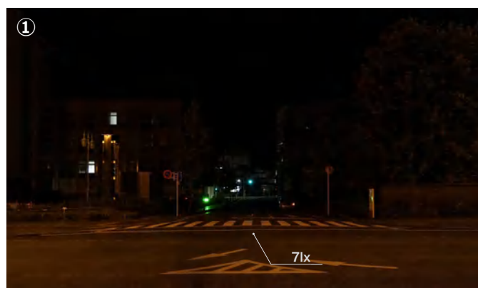
歴史と文化の道と電車通りをつなぐ、動線として重要な場所にあたるが、夜には道の先が闇に沈んでいて、どこに続く道なのかわからない。
