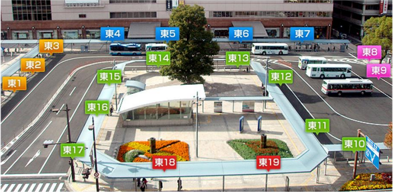
鹿児島中央駅東口バス乗降場の状況 (鹿児島市交通局資料より)
