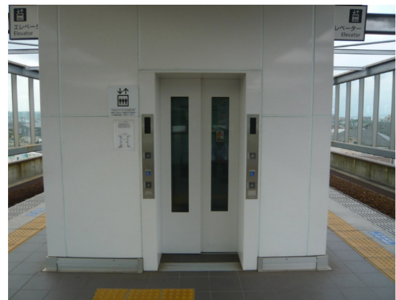
JR 慈眼寺駅のエレベーターの設置 (谷山地区：平成 27 年度整備箇所)
