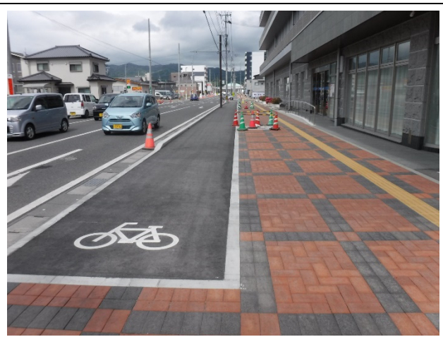
都市計画道路南清見諏訪線の整備
