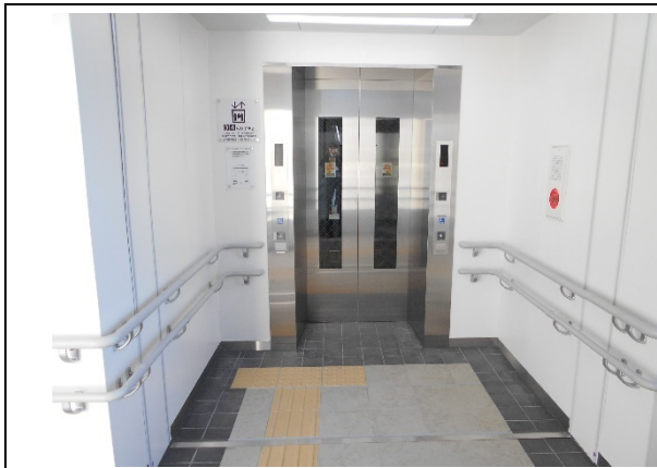
JR 鹿児島駅のエレベーターの設置 (中央地区：令和元年度整備箇所)
