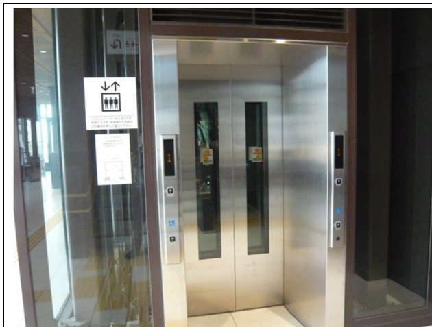
JR 谷山駅のエレベーターの設置
