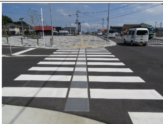
都市計画道路 御所下和田名線の整備 (谷山地区：平成 29 年度整備箇所)
