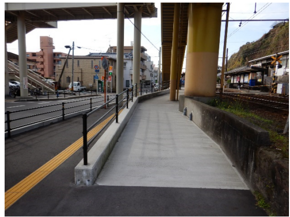
南鹿児島駅前電停出入口通路の整備 (鴨池地区：平成 27 年度整備箇所)
