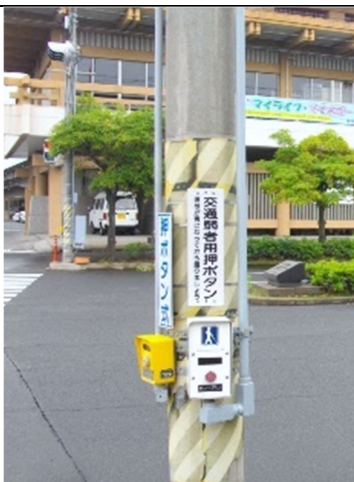
高齢者等感応信号機（武道館前交差点）の設置 （鴨池地区：平成 26 年度整備箇所）
