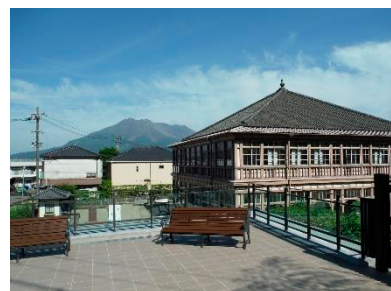
旧鹿兒島紡績所技師館（異人館）
