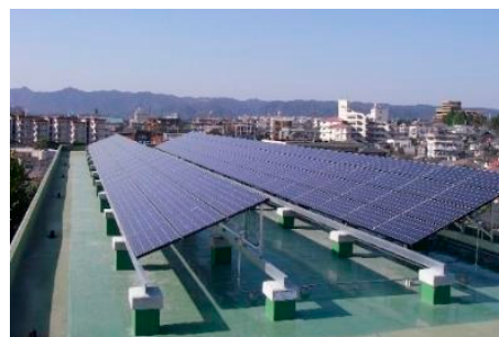
市有施設の太陽光発電システム
