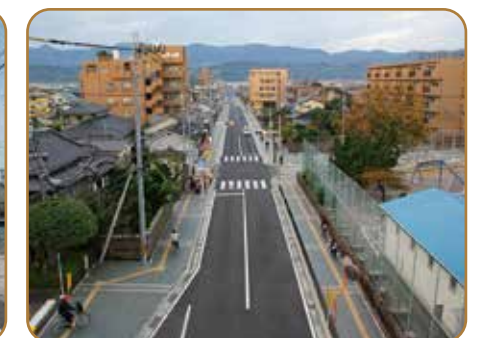
谷山支所前通線の整備
