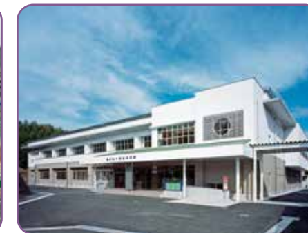
郡山体育館の建設
