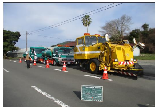
道路降灰除去作業
