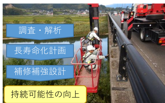
公共インフラ長寿命化の調査
