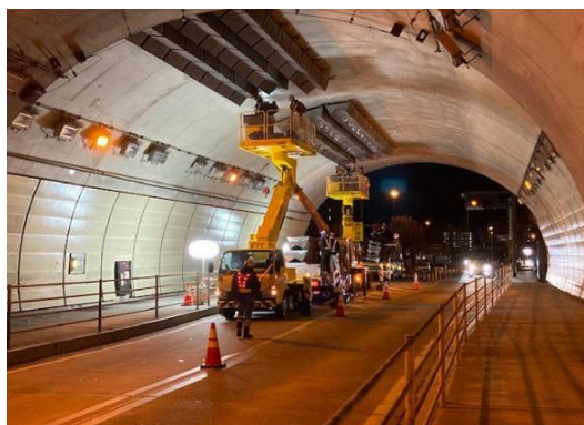
ゴール9, 12(インフラ整備【トンネル補修工事】)
