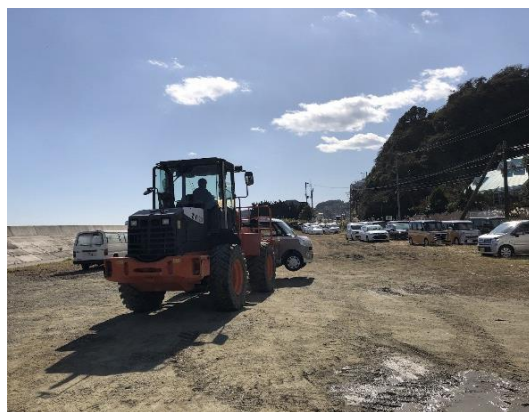
(被災地での車両の撤去・保管作業)
