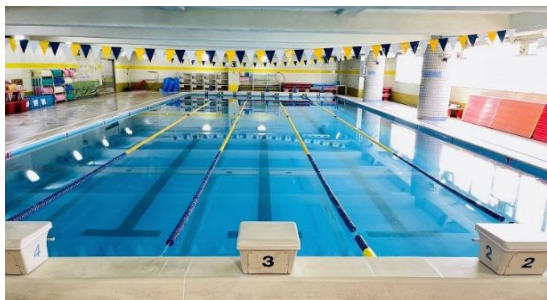
(プール内全照明LED化)
