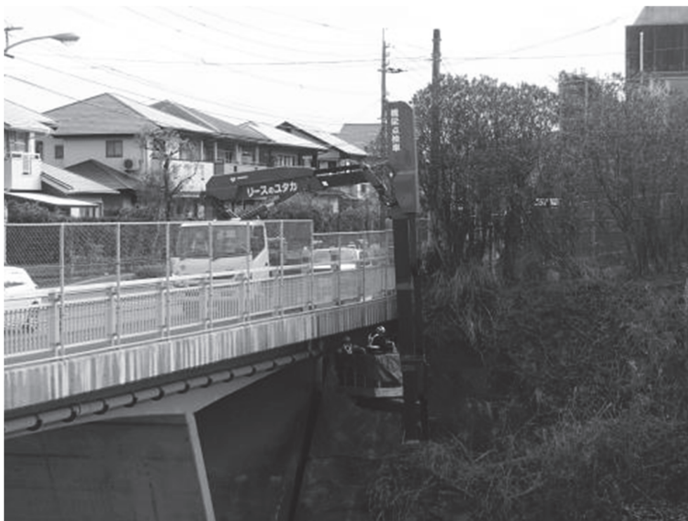
橋りょうの点検
