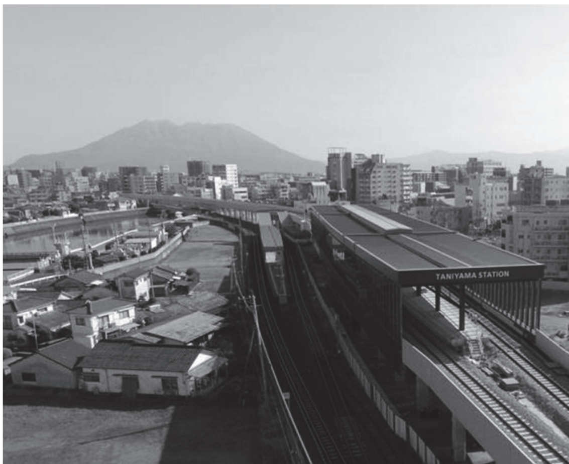
谷山地区連続立体交差事業
