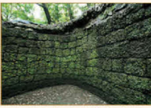
堆積凝灰岩的炭窯牆壁 巨大炭窯的牆壁以及窯口是將很厚的凝灰岩堆積成弧形狀建造而成的。耐高溫、能夠支撐土製圓頂屋頂是非常牢固的結構。
