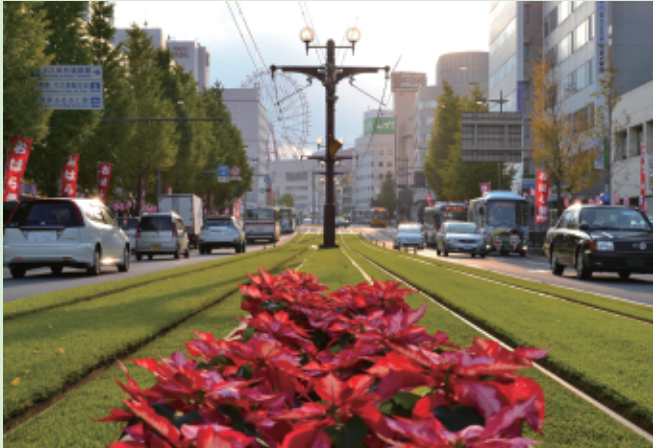
市電軌道敷緑化整備事業
