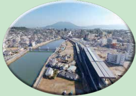
谷山地区連続立体交差事業
