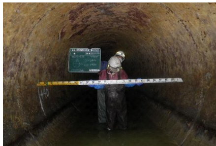
汚水管路 工事前
