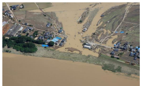
堤防決壊による家屋の流失(鬼怒川)
