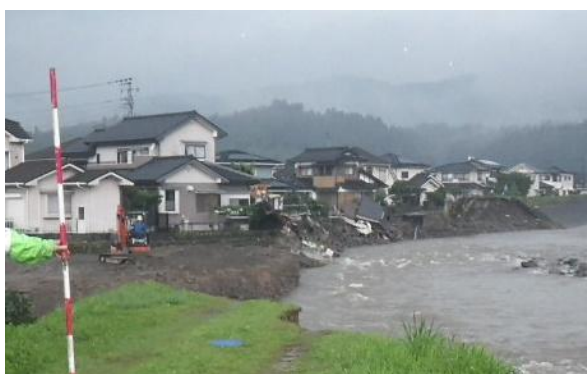
河岸侵食による家屋の倒壊(花月川)
