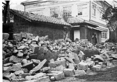
▲地震による市街地側の被害
