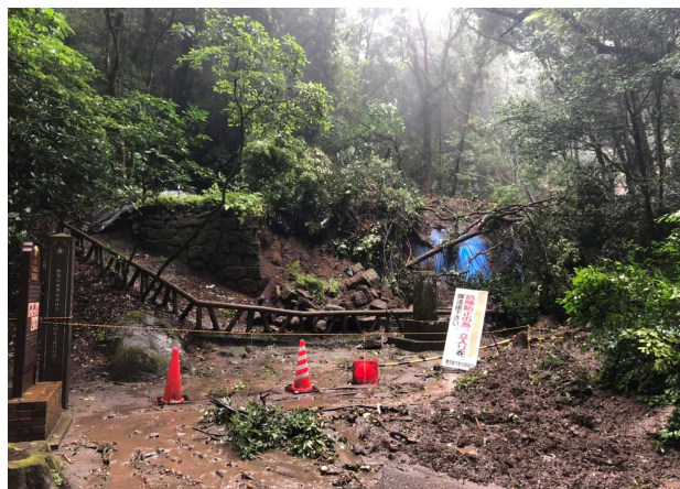
写真 寺山炭窯跡の被災状況
