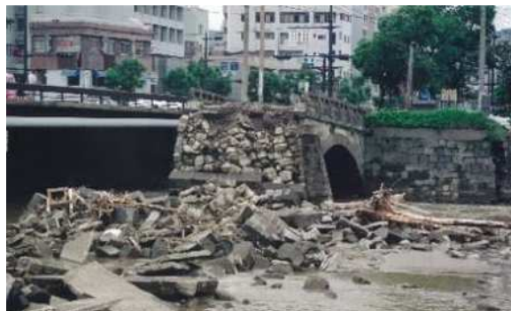
【8.6 豪雨災害(武之橋)】
