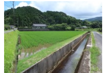
仮屋崎用水路
