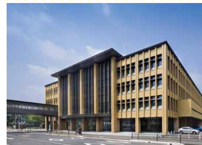
鹿児島市役所本庁舎の整備（西別館）
