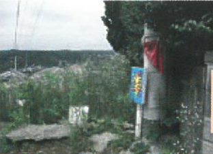
④二丁目26付近 フェンス有, 急斜面
