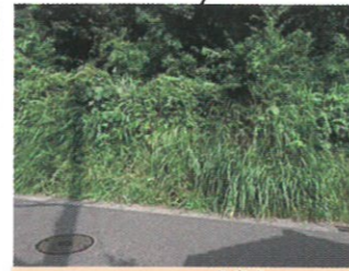
⑨四丁目37付近 奥にフェンス有, 藪
