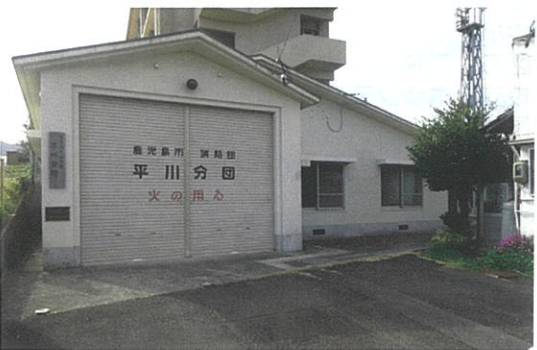
鹿児島市消防団平川分団車庫・詰所
