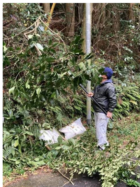
防犯灯の保守点検（伐採作業）
