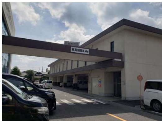
【解体予定の別館】
