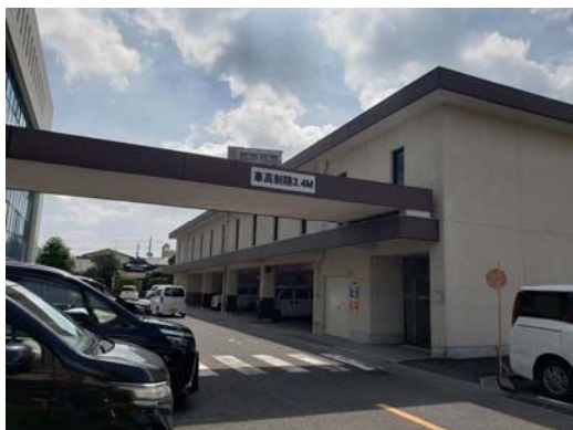
【解体予定の別館】
