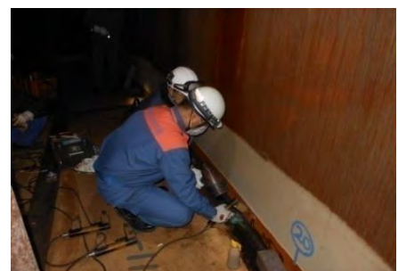
石油タンク内部の検査
