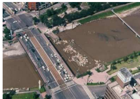
決壊した五大石橋（武之橋）
