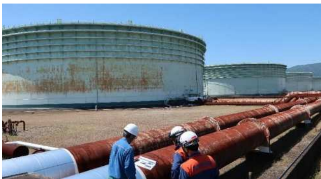
石油タンク検査
