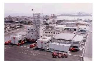
消防総合訓練研修センター
