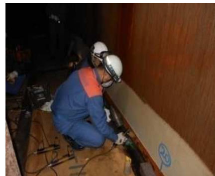
石油タンク内部の検査
