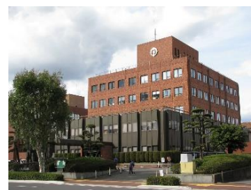
水道局本庁舎
