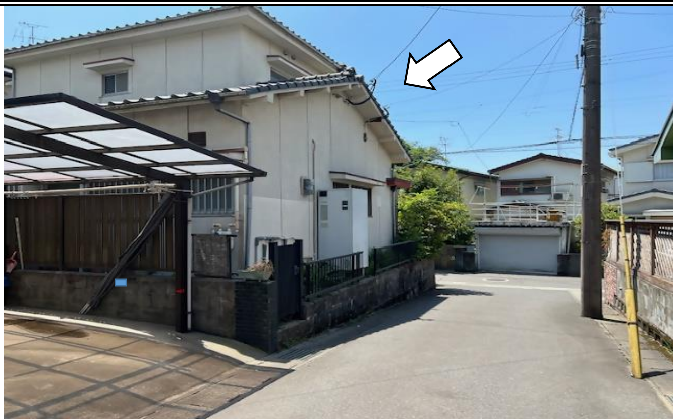
北西方から撮影
